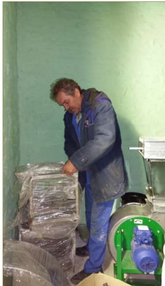
Монтаж систем вытяжной вентиляции
