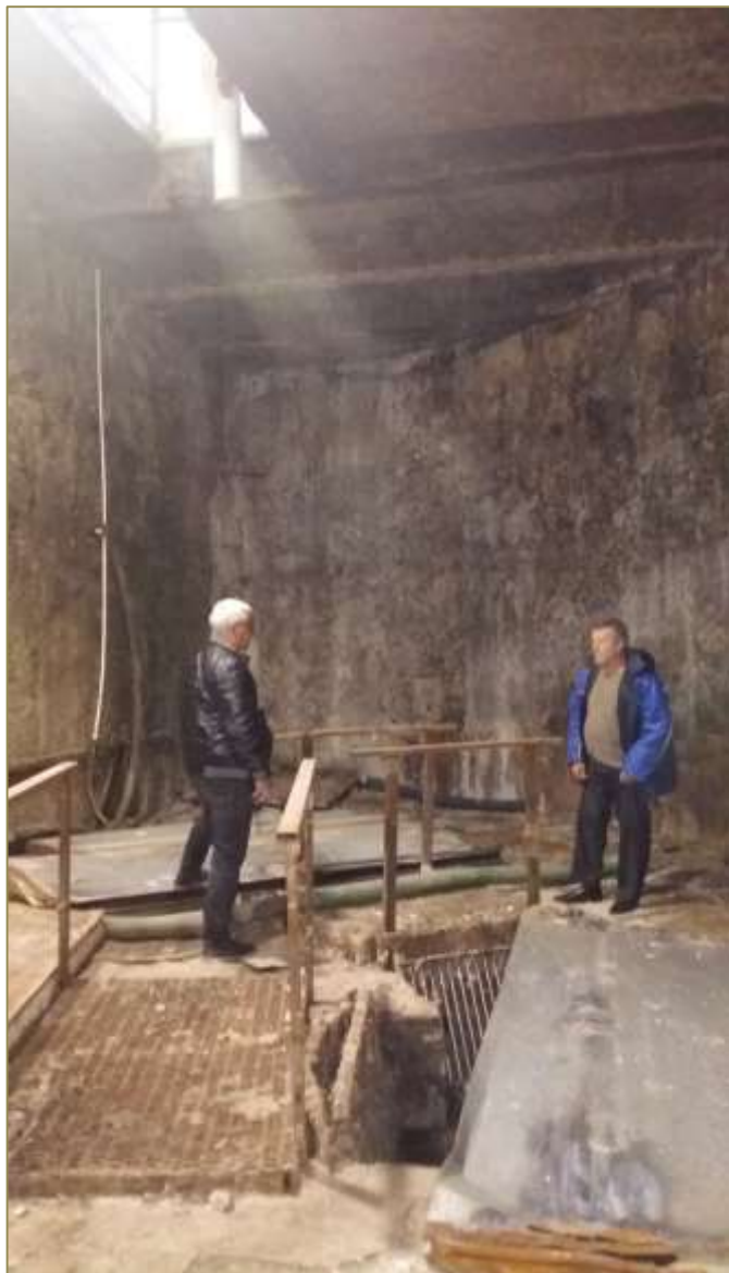
Замена покрытий каналов
