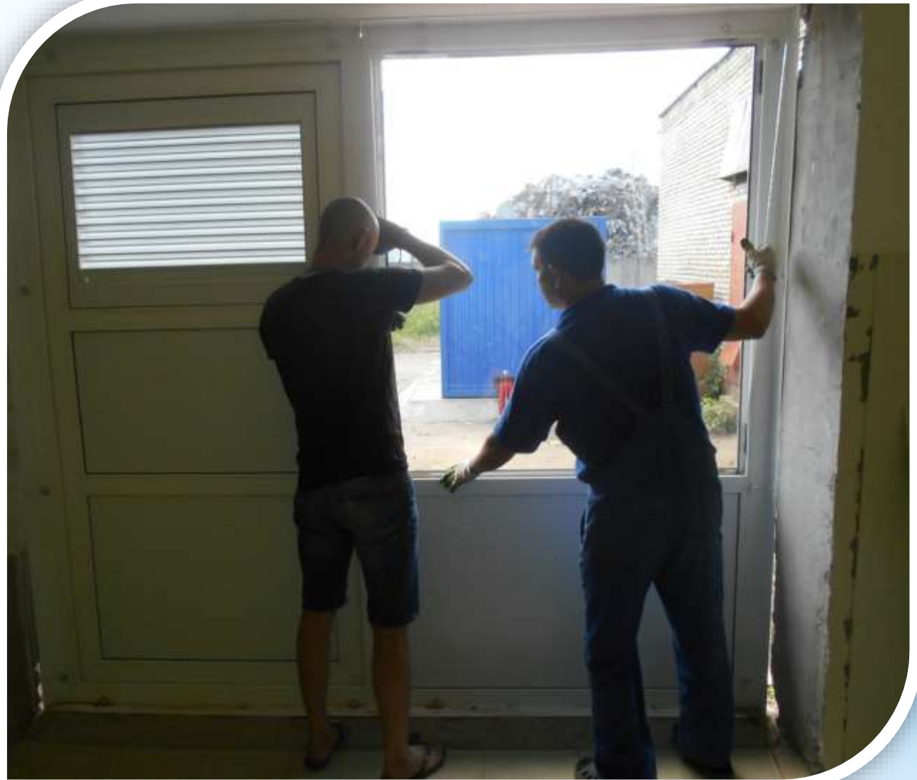
монтаж легкобрасываемой конструкции ПВХ
