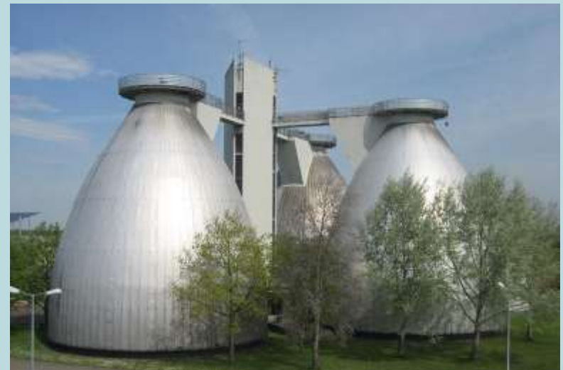
Очистная станция Вайнхайм (Германия)
