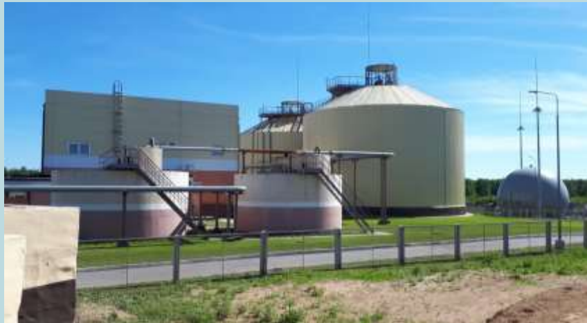
Очистные сооружения в г. Иваново
