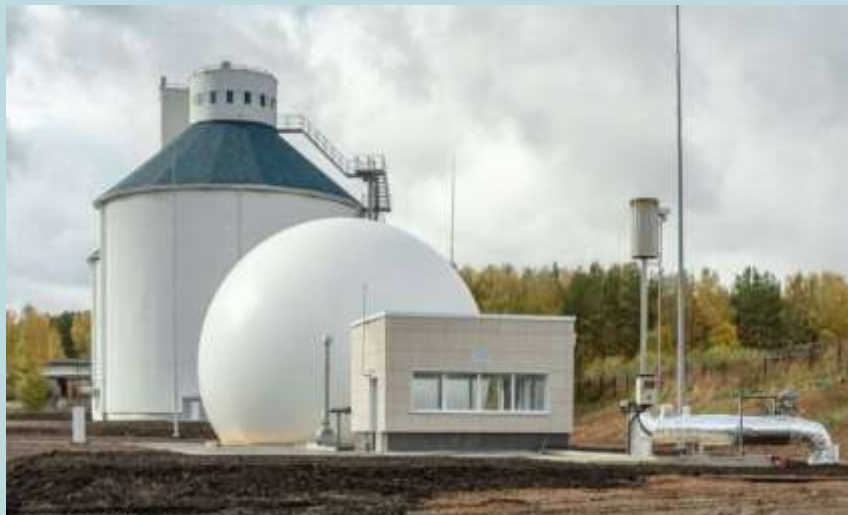
Очистные сооружения в г. Екатеринбург
