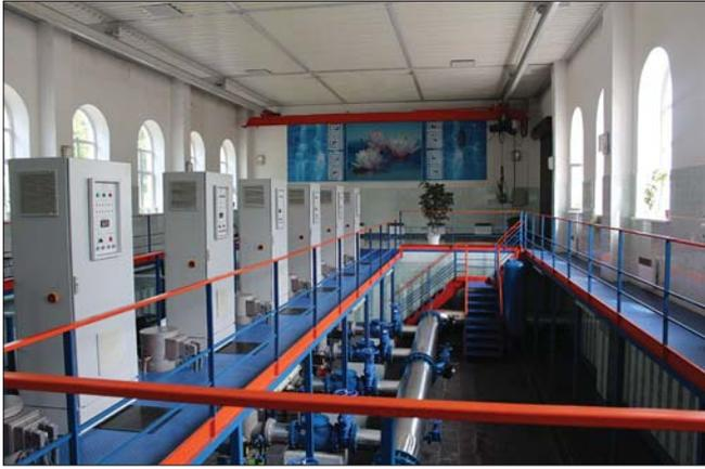
Реконструированы канализационные насосные станции № 1, 2, 7, 8 с внедрением энергоэффективного насосного оборудования фирм *Grundfos* и *ABS*, с применением измельчителей, что позволило перейти на работу КНС в автоматическом режиме. Проведена реконструкция цеха обезвоживания осадка с установкой декантеров.
