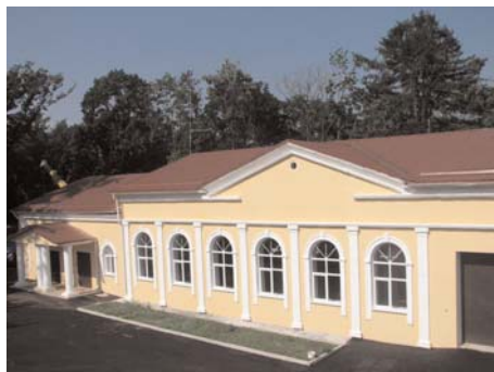
ВЗУ «Центральный». Машинный зал насосной
