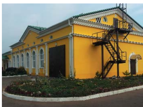
ВЗУ «Туристический». Резервуар чистой воды
