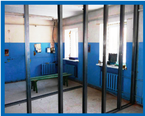
г.о. Климовск – АБК ОС - устройство перегородок
