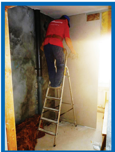
п.г.т.Львовский – капитальный ремонт здания АБК ОС – устройство перегородок санузла
