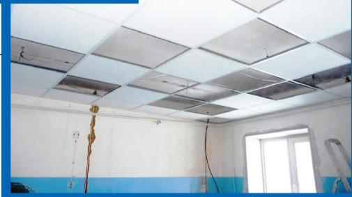
г.о. Климовск – АБК ОС - устройство подвесного потолка
