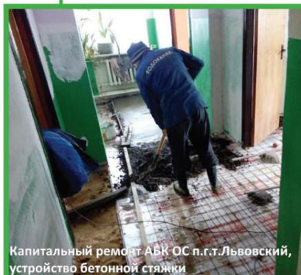
Капитальный ремонт АБК ОС п.г.т.Львовский, устройство бетонной стяжки
