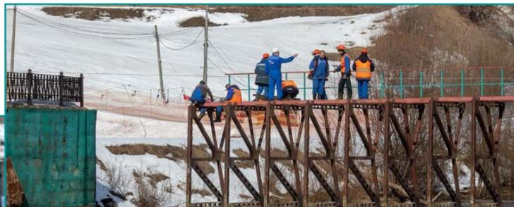
Для того, чтобы пропустить образующий заторы лёд, на плотине временно демонтированы металлические фермы, предназначенные для щитов, регулирующих уровень воды. Вероятность подтопления берега минимизирована.
