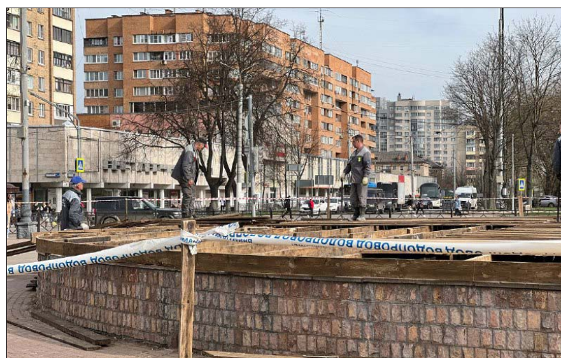
Специалистами проводится очистка чаш фонтанов, проверка состояния инженерных систем, регулировка высоты струй, благоустройство прилегающей территории
