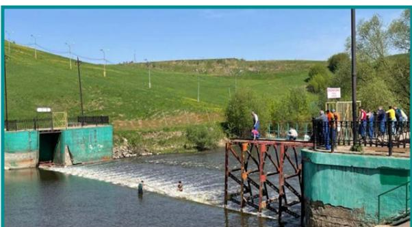
Капитальный ремонт ГТС р. Пахра /Изготовление/ установка щитов Буле
