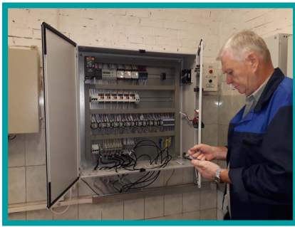
Инженер КИПиА В.А. Башлыков. Наладка станции управления насосным агрегатом (СУНА) в ВПНС.
