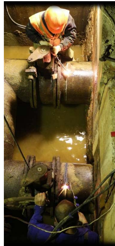
Работы на ВНС «Сынково». Замена затворов на ВНС «Товарная».
