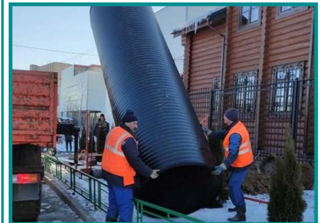
Восстановление колодцев с помощью ПЭ труб на коллекторе д-700мм по ул. Тепличная
