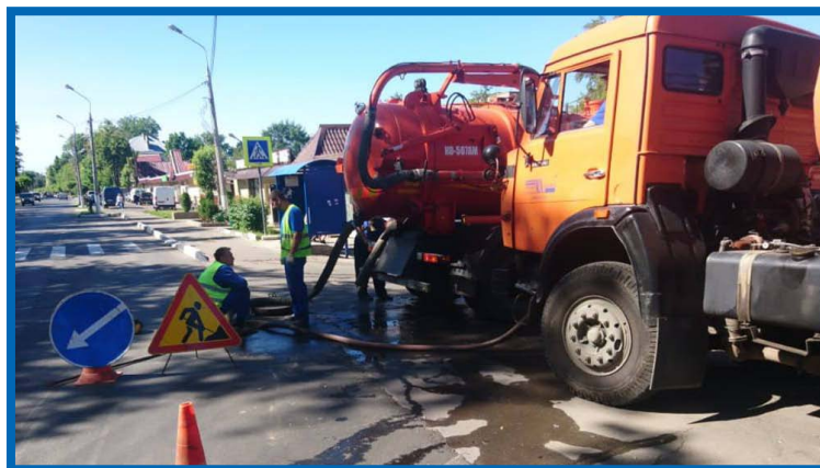
Чистка колодца мкр.Климовск, ул. Ленина
