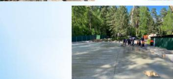
Реконструкция городских очистных сооружений хозяйственно-бытовых стоков по адресу: г. Подольск, Домодедовское ш, д. 255. Организация площадки приготовления почвогрунта (устройство каркасно-тентовых ограждающих конструкций). Устройство фундамента под навес (ангар)
