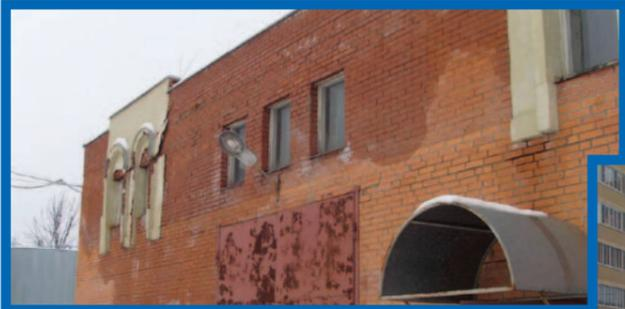
Станция обезжелезивания п.Львовский – многочисленные протечки воды с крыши здания по стенам, с образованием наледи.
