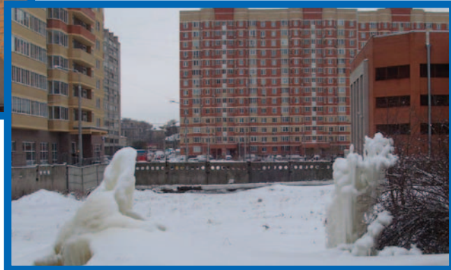
Утечка воды на трубопроводе от арт./скв. № 91, наморожены горы льда
