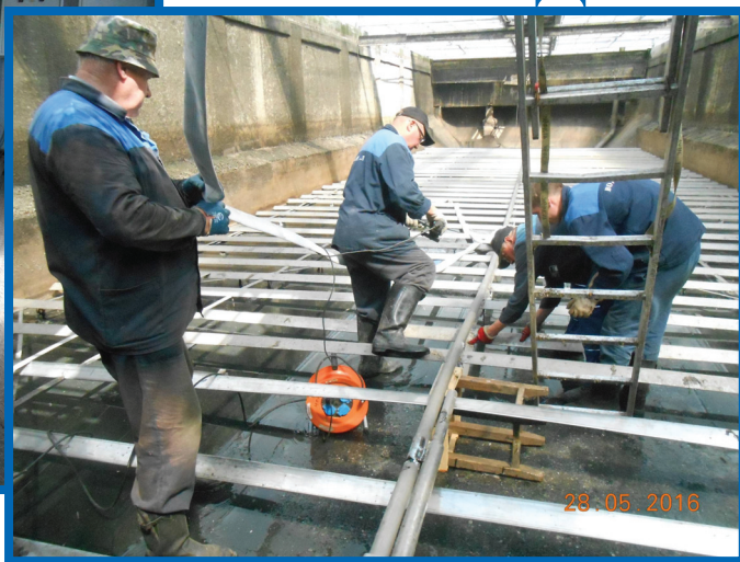
Капитальный ремонт вторичных отстойников
