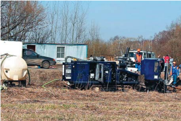
Воинская часть Сырково - прокладка водопровода
