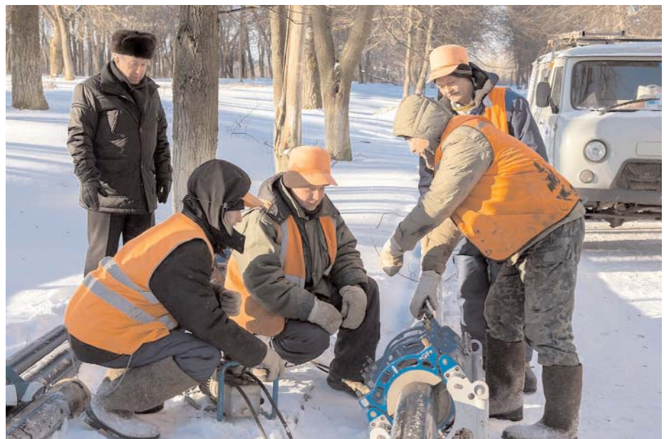
п. Дубровицы - реконструкция участка водопровода
