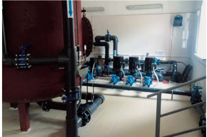
Реконструкция ВЗУ Быково
